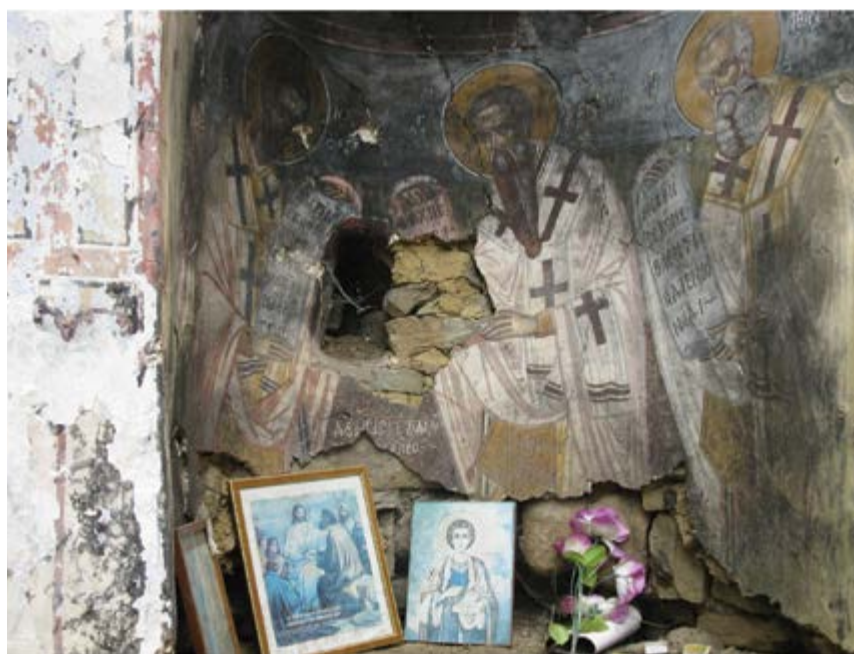
Сн. 23. Олтарът на полуразрушената църква „Св. Николай“ в Бобощица.
