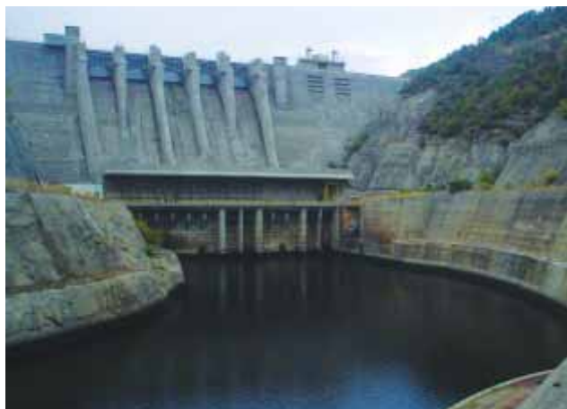
Το φράγμα της Πλατανόβρυσης στον Νέστο (Φωτογραφία Μ. Κουτράκης)
